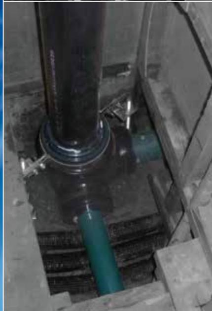
建物用耐火性硬質ポリ塩化ビニル管・継手
