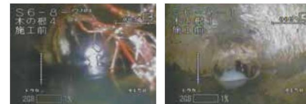
● 管の継ぎ目から木の根が侵入 ● ゴミ・油による管路の詰まり
