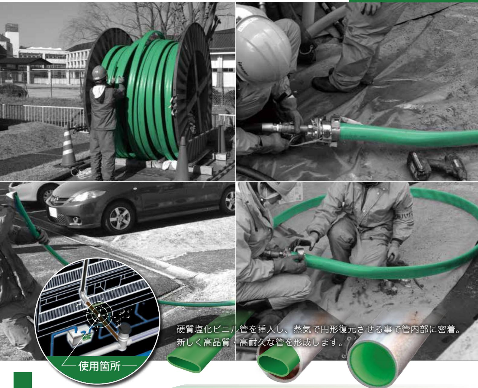
硬質塩化ビニル管を挿入し、蒸気で円形復元させる事で管内部に密着。新しく高品質・高耐久な管を形成します。
