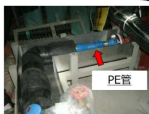
新規PE管施工後
