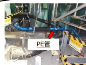
新規PE管施工後
