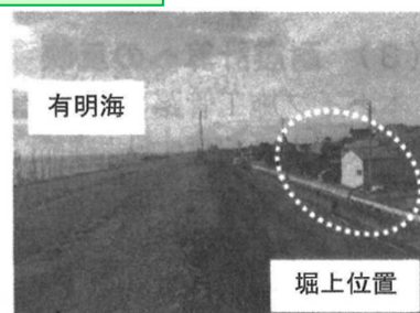
写真1 調査現場の状況
