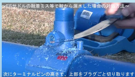
サドルの上部を切除
