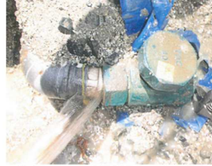
熊本地震における給水装置の被害事例(熊本市)
