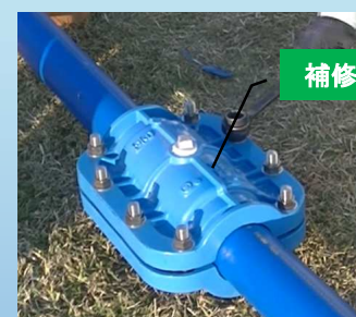
袋ジョイントのボルト締め
