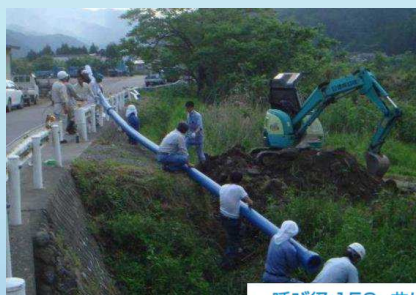
呼び径 150、曲げ半径 25m での生曲げ配管例
