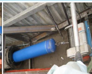
管の引き込み
