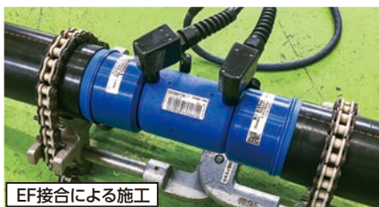
EF接合による施工
