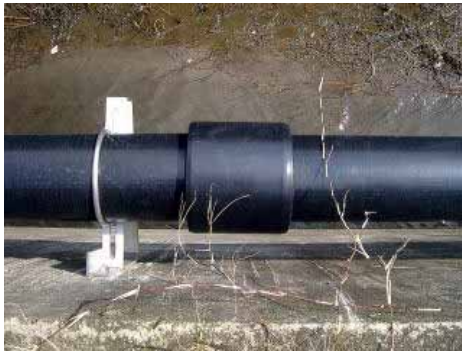
接合には、専用の保護層付きEFソケットを使用。 紫外線による劣化を防止します。
