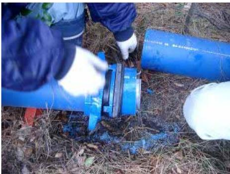
管切断後、端部に栓帽を取り付けます。若干の越し水があるので、メカポリPPキャップ150A [大成機工(株)殿] を使用しました。
