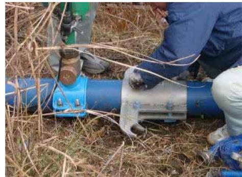
サドルの横にエアバックにより管路が膨張
