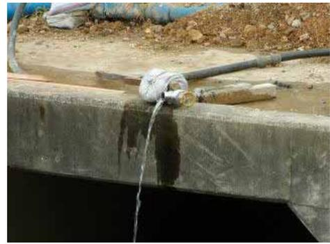
切り回し区間に設置した分岐管の水の勢いが止水確認の目安。水の勢いが低くなれば、止水完了です。
