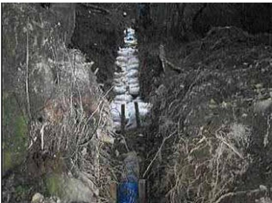
埋め戻し作業において、重機が入れず手掘り、浅埋で対応した現場でも、融着により一体化。抜ける心配がありません。
