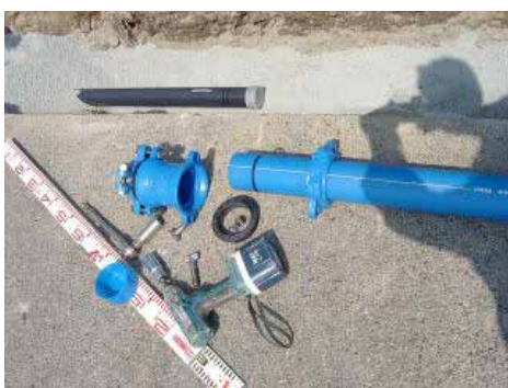
耐衝撃性塩化ビニル管との接続には、メカポリPVジョイントを使用。
