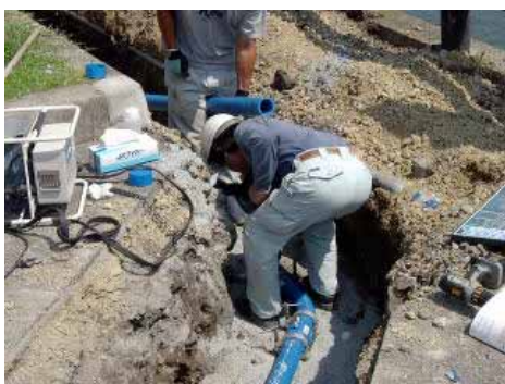
管端の切削と清掃は、重要なポイント、融着面の汚れを確実にふき取ります。
