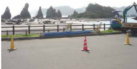
現場は、熊野灘を臨む海岸線。潮風に吹かれながら、施工が開始されました。
