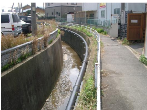
曲げ配管部分（施工当時）
