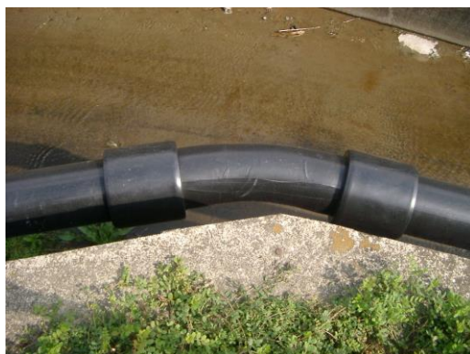
曲管及び接合部（施工当時）
