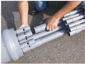
写真2. 接着レスさや管の施工
