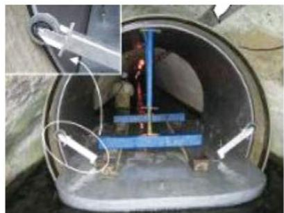
写真4. フローティングサーフ方式
