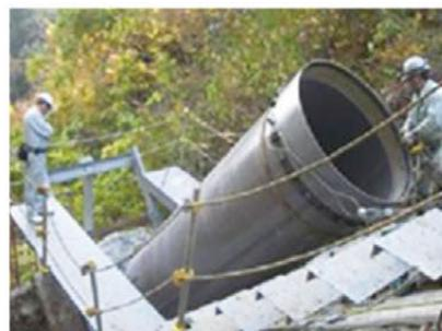
写真3. 急傾斜パイプインパイプ工法
