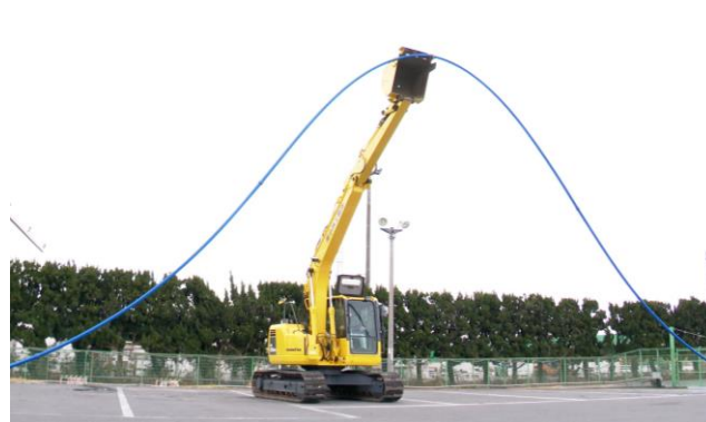
吊り上げによる管の柔軟性確認(呼び径50mm)
