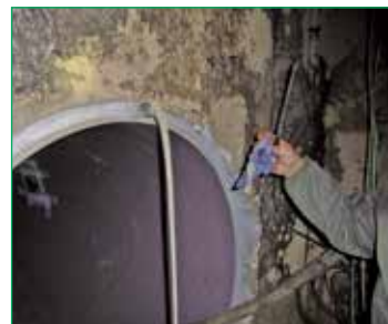
⑥裏込め材打設
