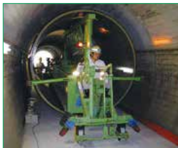
④既設水路内運搬
