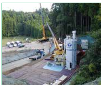
①管搬入立坑の設置
