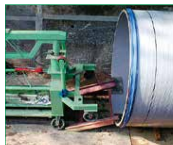
③運搬台車の引き込み
