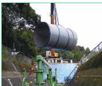
②管の吊降し
