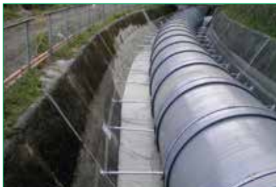
開水路改修(曲げ配管)
