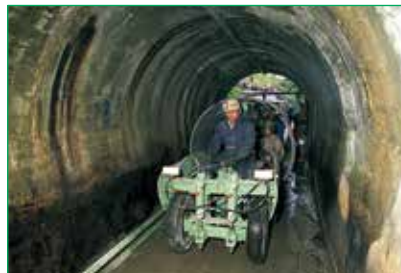
馬蹄形渠改修
