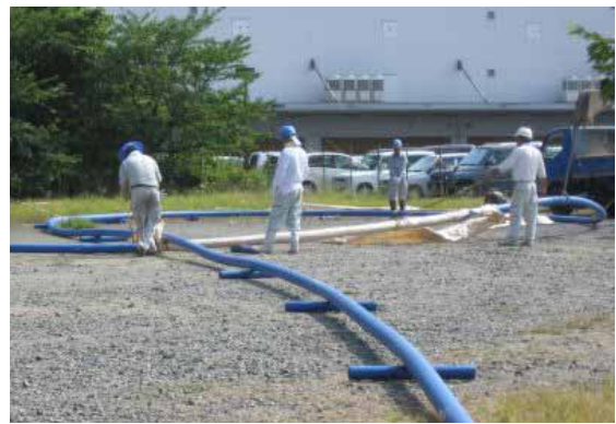
写真9 円形にして仮置きした長尺管
