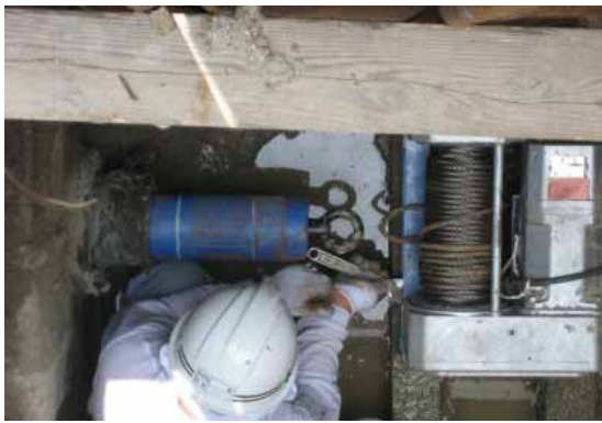
写真10 電動ウインチと到達した先導管
