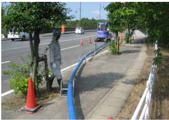
写真8 管引き込み開始時の状況
