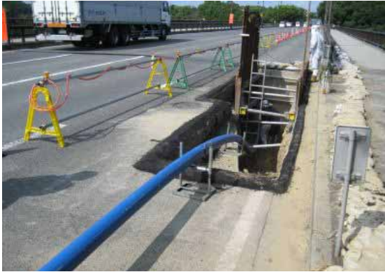
写真6 発進立坑から到達立坑をのぞむ
