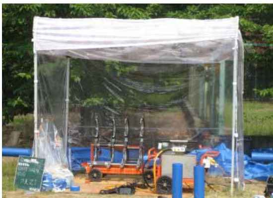
写真4 バット融着専用テント
