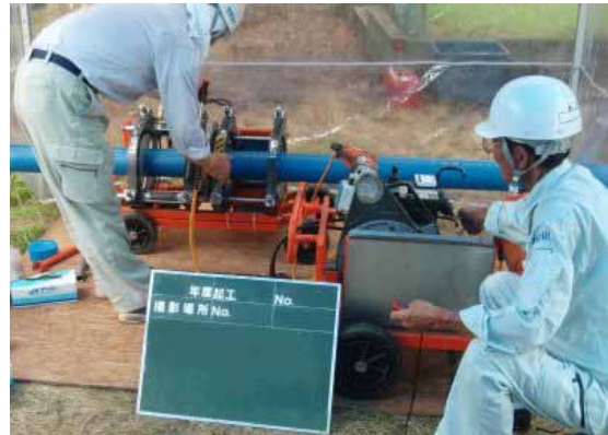
写真5 専用テント内での融着作業
