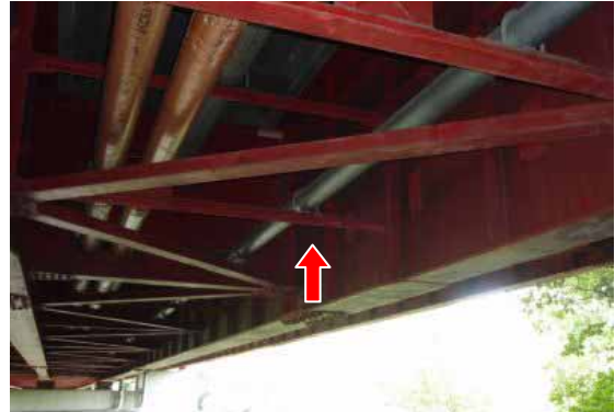
写真2 既設管鋼管SGP 150
