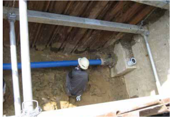
写真7 既設管への挿入
