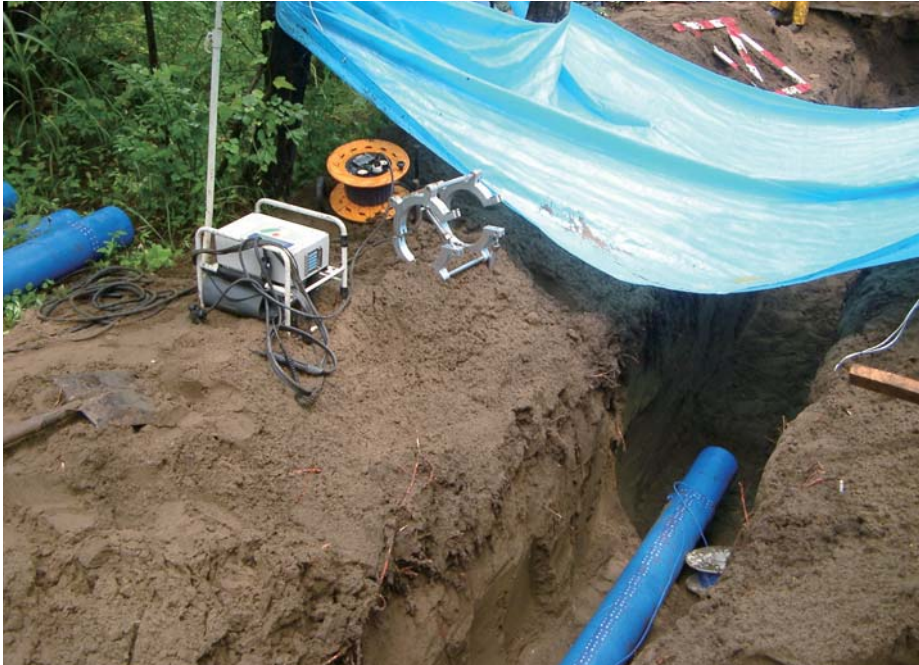
刈羽村・砂丘地でのエスロンハイパー布設工事風景
