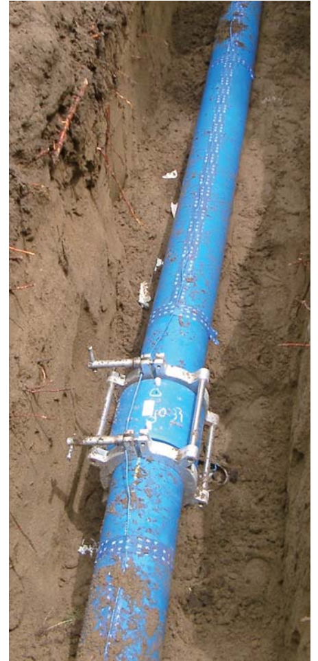
平成15年度刈羽地区に布設されたエスロンハイパー
