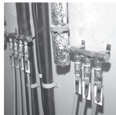
さや管ヘッダー式配管システム
