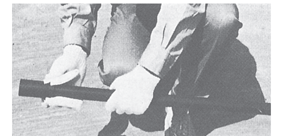
写真-5 清浄処理
