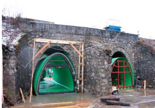
シベリア鉄道補強工事
