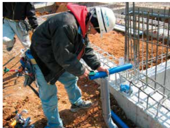
●融着面の切削(ハンスクレーパー)
