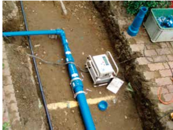
●外構配管施工
