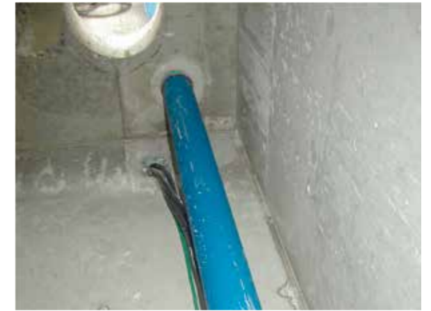
●モルタルを埋め戻した状態
