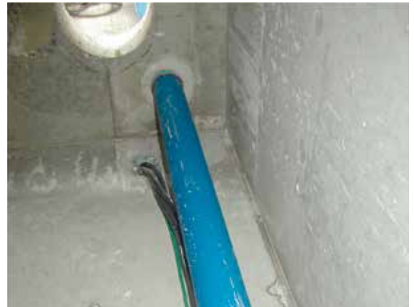
● モルタルを埋め戻した状態
