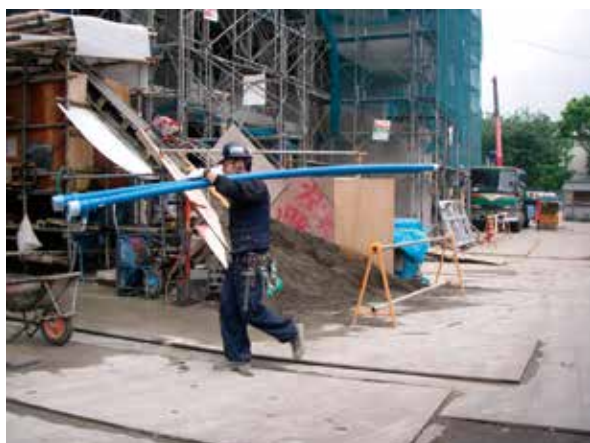
● 軽量性を活かした管の運搬
