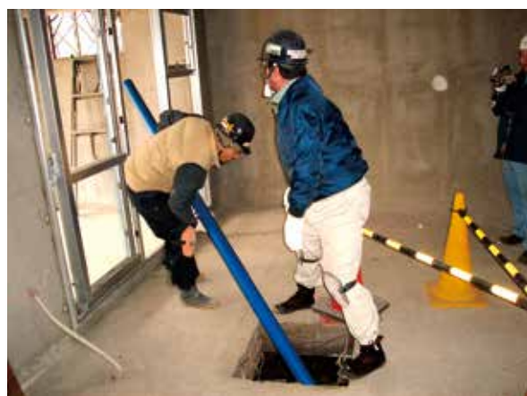
● 柔軟性を活かしたピット内への管の搬入
