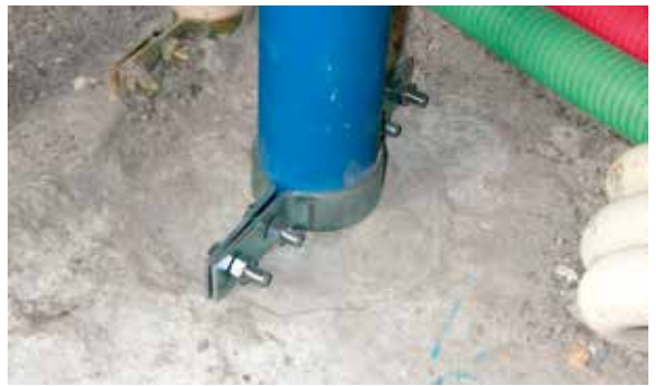
●床バンドを用いた支持固定(※コンクリート増し打ち前)
