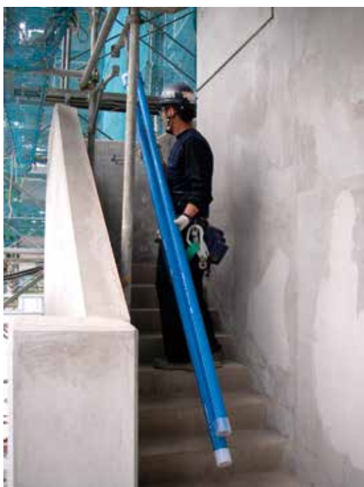
● 狭小スペースでの管の運搬
