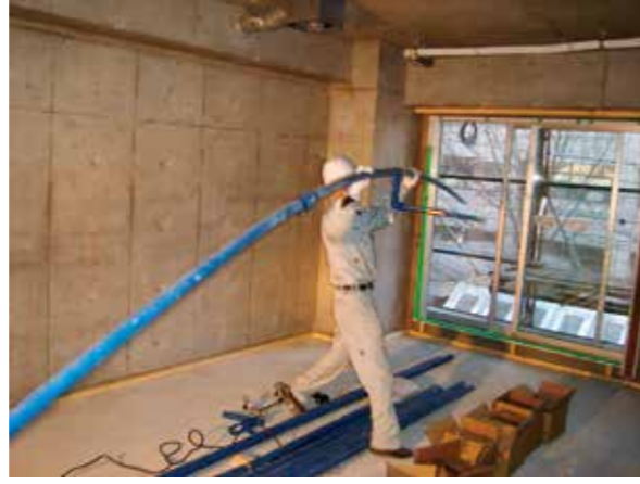
●直管をプレハブ化した施工
