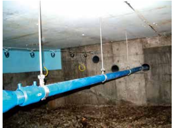
● スリーブ貫通箇所付近
