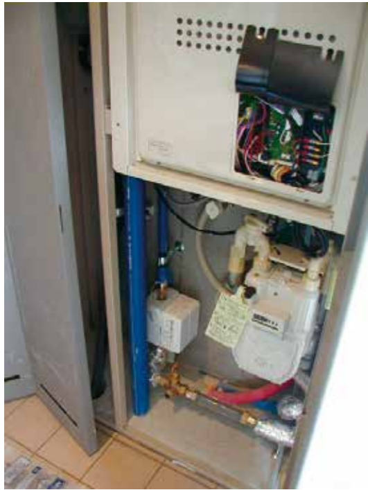
●パイプシャフト内
