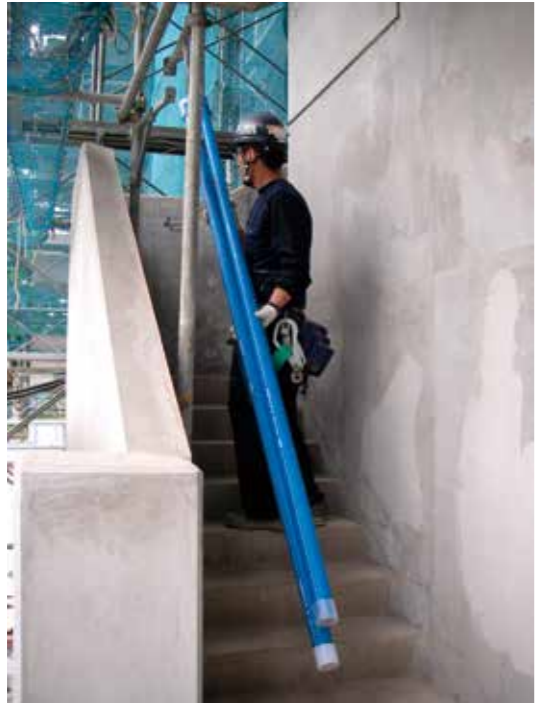
●狭小スペースでの管の運搬
