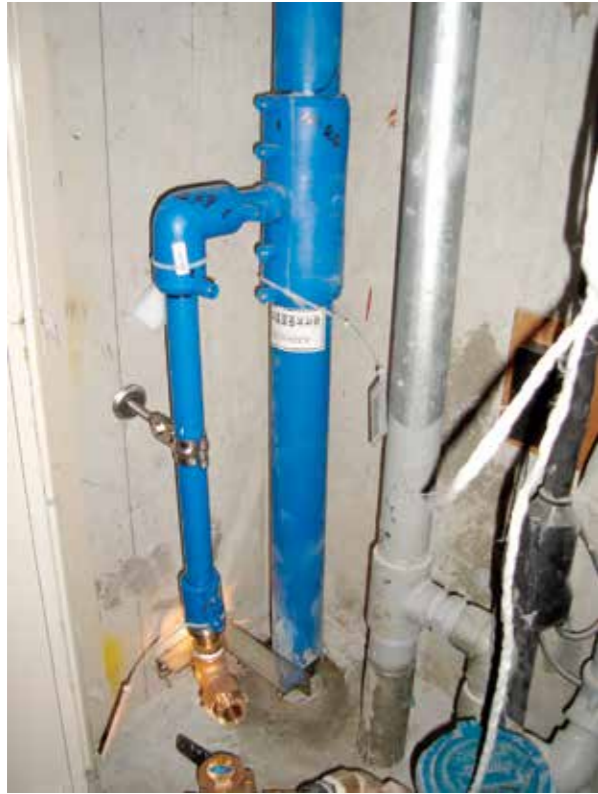
●パイプシャフト内
