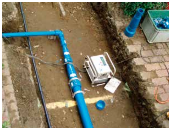
●外構配管施工
