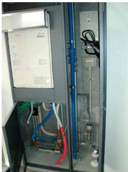
●パイプシャフト内
