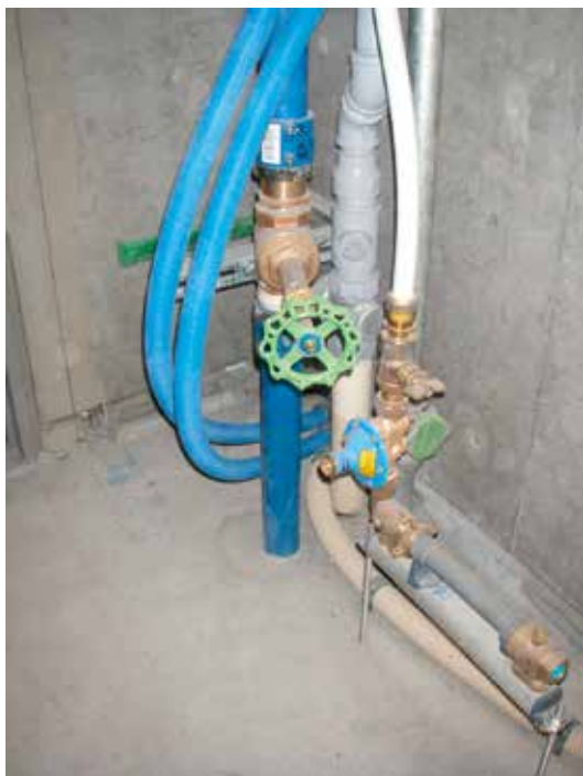
●最下階ゲートバルブ付近
