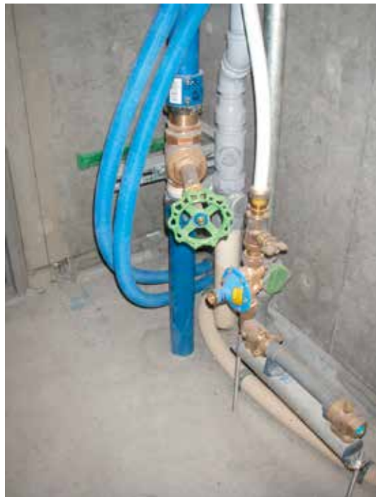
●最下階ゲートバルブ付近
