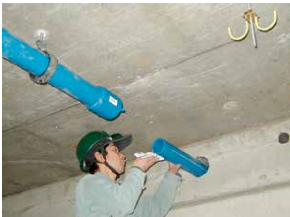
● 管・継手の清掃
