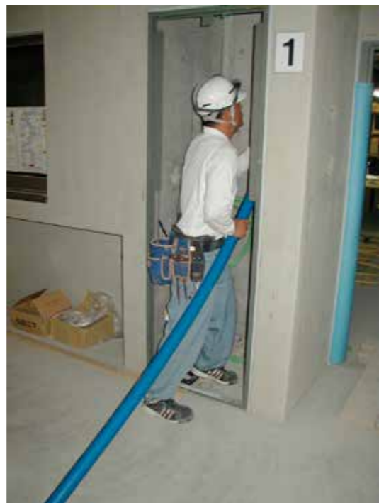
●柔軟性を活かしたPS内への管の挿入
