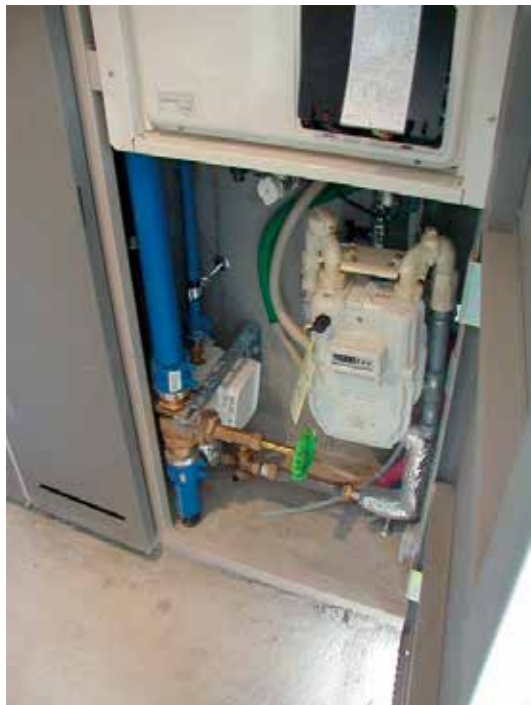
●最下階ゲートバルブ付近
