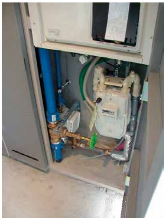
●最下階ゲートバルブ付近
