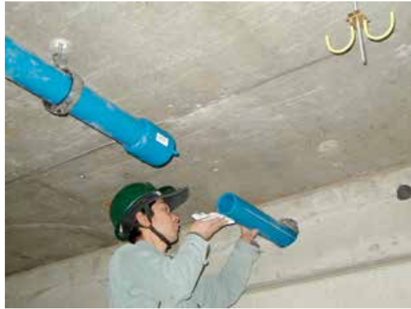
●管・継手の清掃
