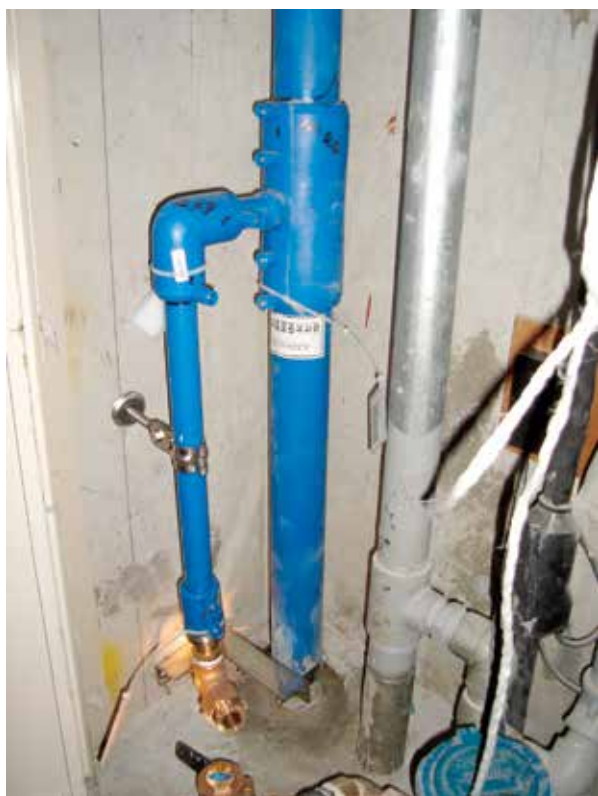
●パイプシャフト内
