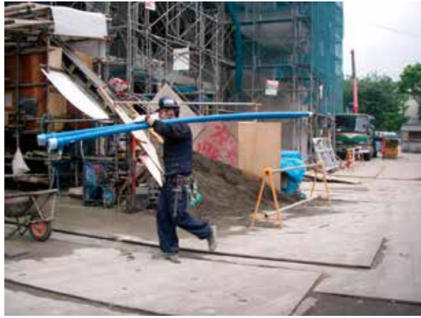
●軽量性を活かした管の運搬
