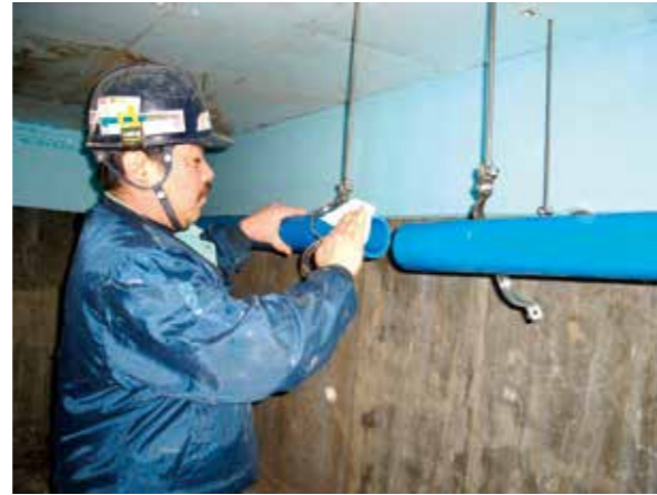
●管・継手の清掃
