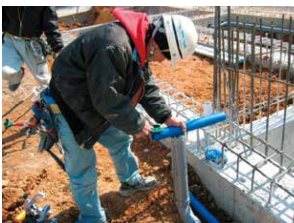
● 融着面の切削(ハンドスクレーパー)
