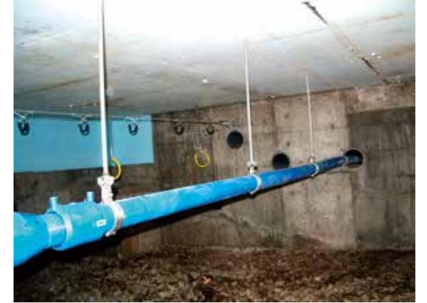
●スリーブ貫通箇所付近
