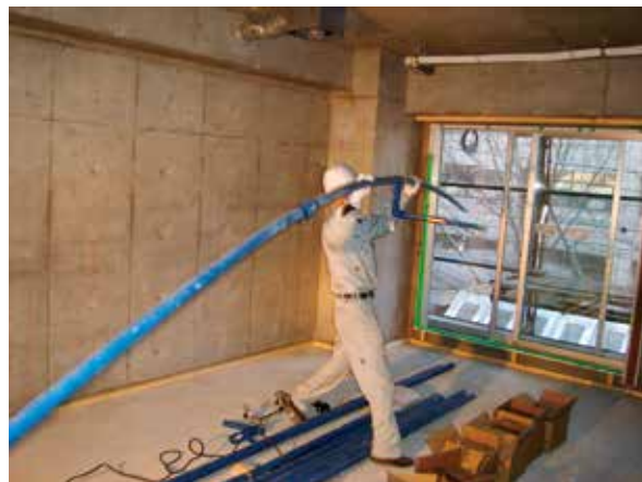
● 直管をプレハブ化した施工
