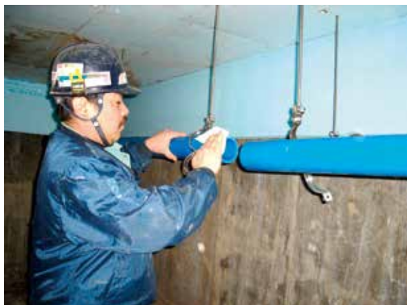
● 管・継手の清掃
