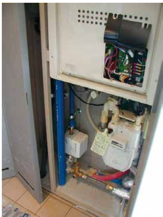
●パイプシャフト内
