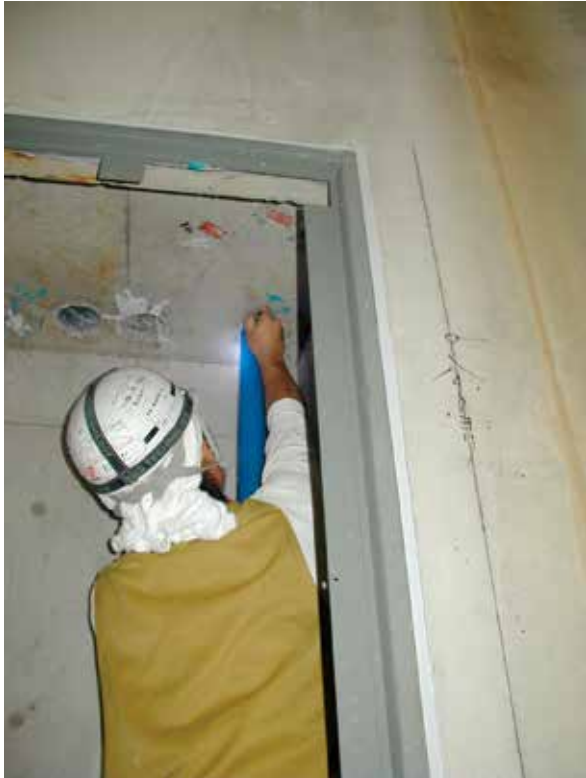
● フィブロック巻き付け位置の墨出し
