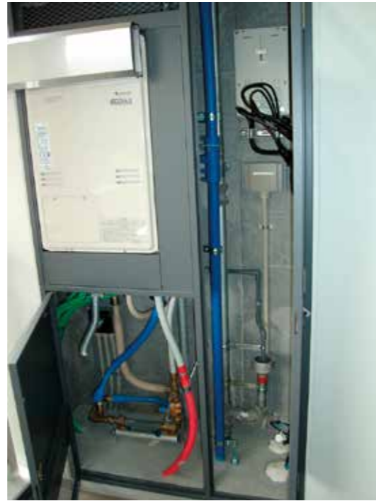
●パイプシャフト内
