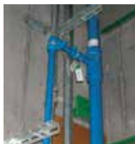
パイプシャフト内
