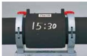
インジケーターが左右とも継手表面より隆起していることを確認し、(250A以下)、更に、継手受口部の管にスクレープ余長があることを確認した後、冷却終了時刻と施工者名を継手表面にペン等で記入してください。
