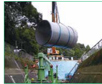
②管の吊降し
