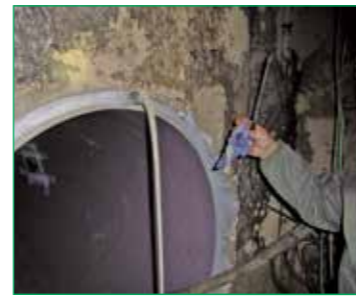
⑥裏込め材打設
