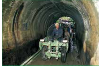
馬蹄形渠改修
