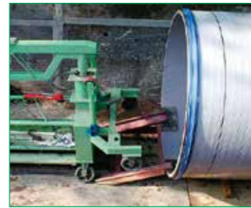
③運搬台車の引き込み
