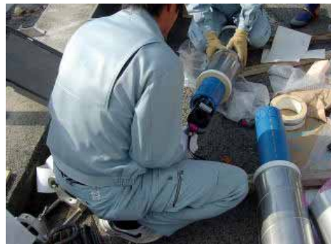
カーブに対応するため、被覆付乱尺直管(3m)と11 1/4°曲管を使用しました。
