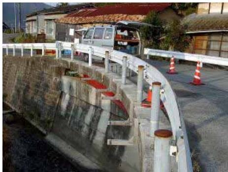
施工現場となった橋梁部分。道なりに緩やかにカーブしています。曲部の半径は、約18mです。
