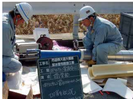
乱尺直管の片端は、外装管及び発泡層が取り外し出来る構造になっています。現場で簡単に切管、長さ調整が可能のため、設計変更が容易です。
