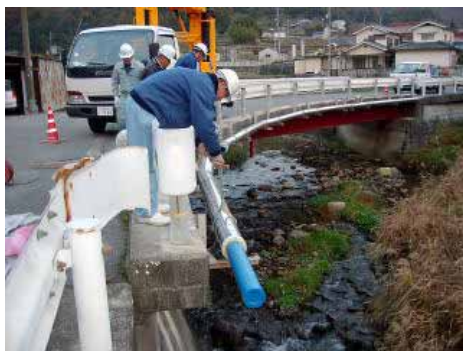
施工時には、実際に部材を用いて位置あわせを行い、設計との誤差を修正していきます。ハイパー被覆付管は軽量なので、人力でも持ち運び出来ます。
