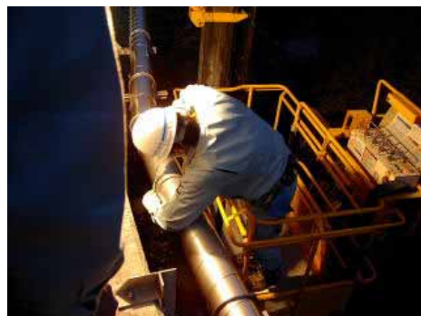
接合部にカバーを取り付けて、施工完了。約2.5mの布設を1日で施工することが出来ました。
