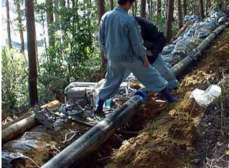
[ 事例1 ] 山間傾斜地での施工 エコハイパー JW150Aの施工状況。 150 - 5mの管重量は、約50kg / 本。 重機が侵入できない山間部でも、人力で小運搬 出来ます。
