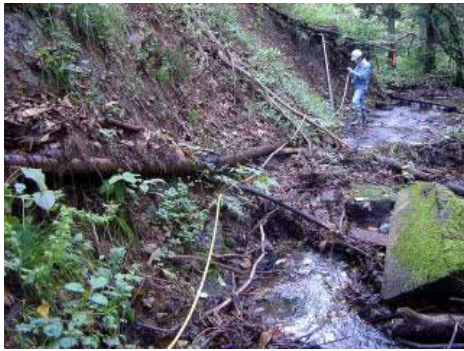
[ 事例 3 ] 破損管路の復旧 土砂崩れにより、破損した導水管 7 5 A の復旧 作業にエスロハイパー JW 7 5 A を使用しま した。
