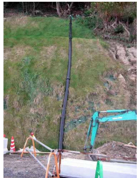
[ 事例2 ] 急傾斜地での施工 急傾斜部分など、掘削が困難な場合でもエコハイパー なら、紫外線劣化の心配がありません。安心して 使用できます。
