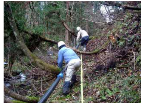
[ 事例 3 ] 破損管路の復旧 柔軟性のあるエコハイパーなら、足場が悪い山間 部でも、樹木を避けながら布設場所まで運び込め ます。
