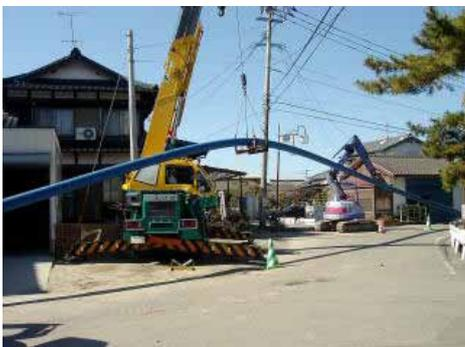
推進工事直前、管を水路からクレーンで吊り
