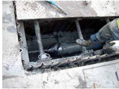
管の先端が、反対側の立坑に到達。
