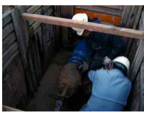
管が立坑に到着。外表面に大きな傷もなく、後日、両端を既設管と接合、無事工事を完了しました。(引き込み速度 約0.25m/分)
