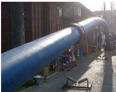
管を吊り上げながら、少しずつ引き込んでいきます。ポリエチレン管の柔軟性と融着による一体化が役に立ちます。
