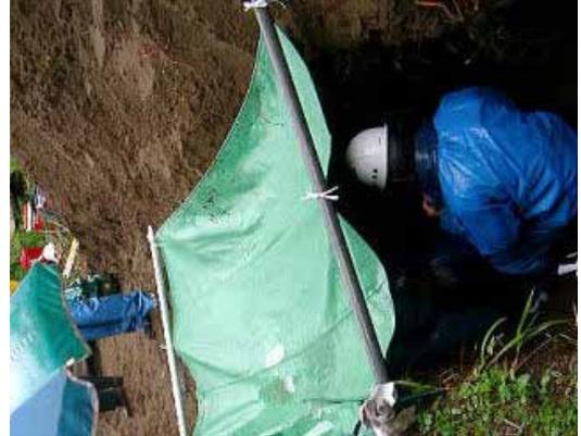
鋼管にシートを結び、掘削溝に設置しました。継手の下にもシートを敷き、施工しています。
