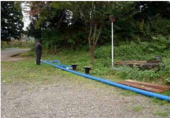
現地で陸継ぎした上で、山道に沿わせて生曲げ配管しています。
