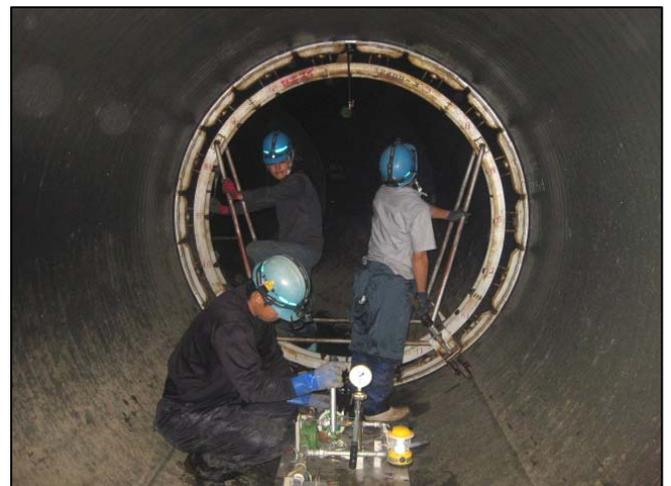
継目試験により水密性能を確認
