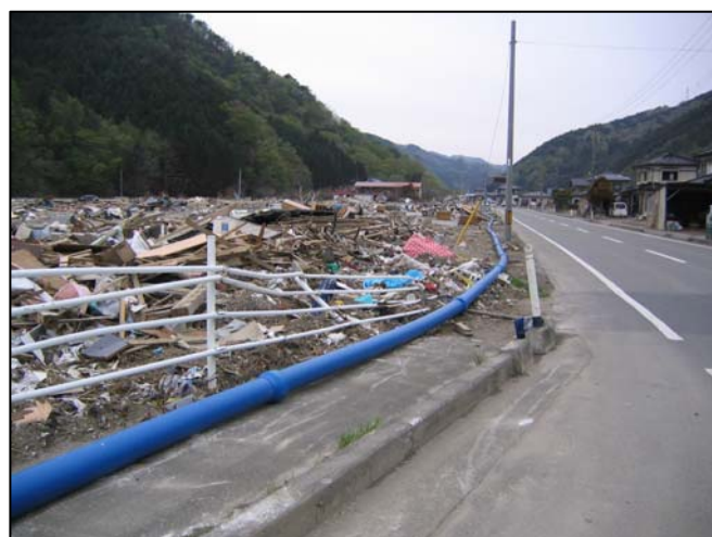
露出配管部(約1,670m)
