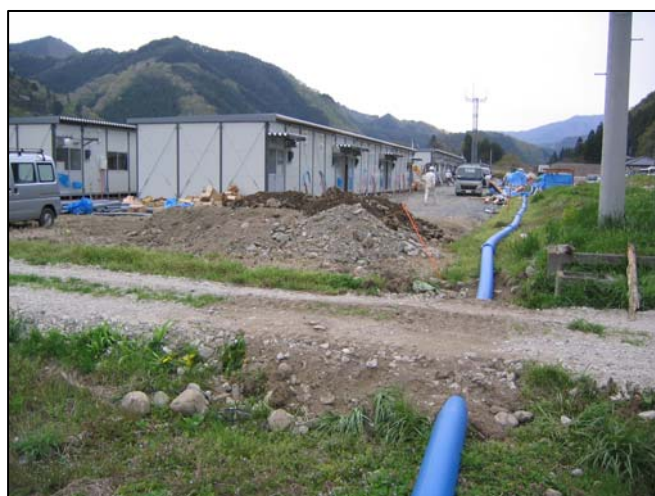
エスロハイパーJWの呼び径150mmを、 仮設住宅への仮設配水管として布設
