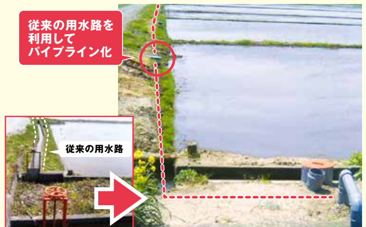
事例.2 従来の用水路をパイプライン化
