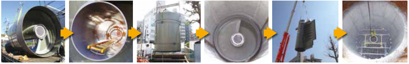
ドロップシャフトを 工事現場に搬入
