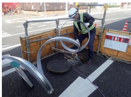
製管(プロファイル送り)
