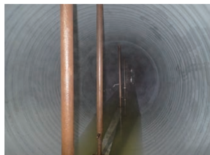
浮上防止設置
