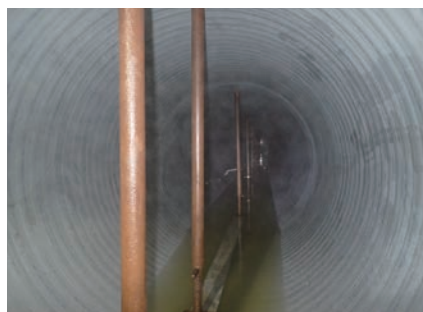
浮上防止設置
