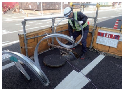
製管(プロファイル送り)
