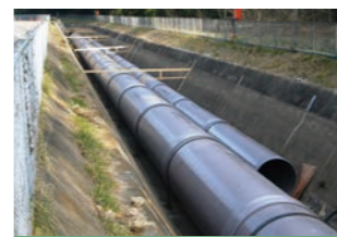
暗渠化(水路内配管)
