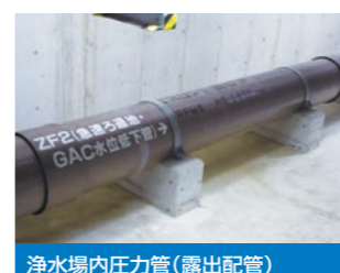
浄水場内圧力管(露出配管)
