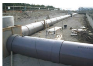
宅地造成(雨水排水管)
