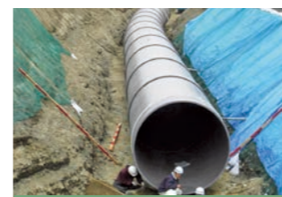
曲げ配管(溝形)
