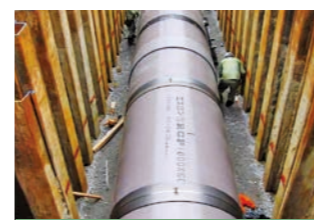
直線配管(圧力管)
