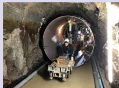
土樽発電所 導水路改修工事
