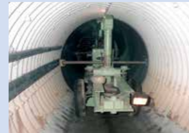
公共下水道御陣屋川第2-1幹線雨水渠築造工事
