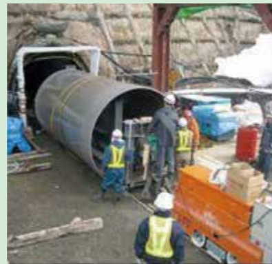
樺戸(二期)農業水利事業徳富ダム 壮志トンネル建設工事
