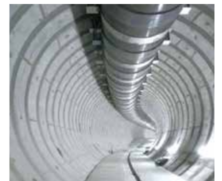
FRPM管設置完了
