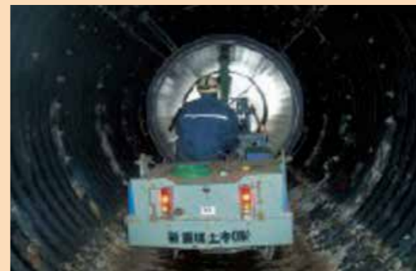
管内排水構造物補修その2工事
