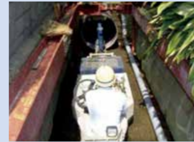
葛飾管渠布設工事(その50)
