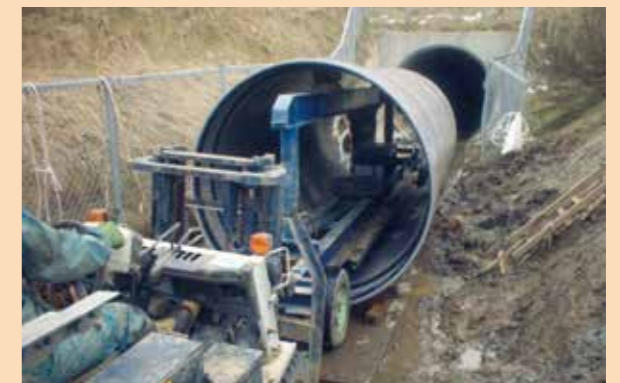
山形自動車道酒田地区排水路補修工事
