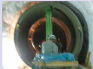
池田市第6次拡張事業配水隧道改良工事
