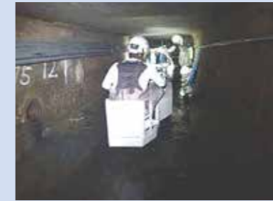
仙台市通町一丁目地区合流管耐震化工事
