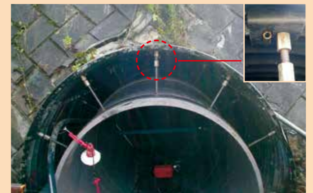
関越自動車道災害復旧工事KP217.866
