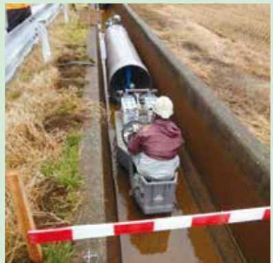
新潟中東地区大形東部用水路 改修工事一次、二次工事
