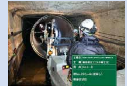
宮浦雨水幹線改築工事(その2)及び御串山樋門修繕工事
