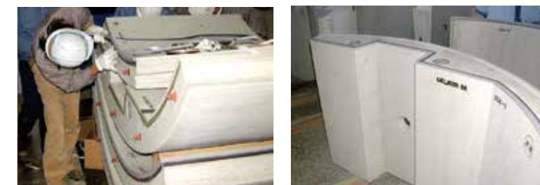
●シーコークの貼付け作業(セグメント組み立て前) ●シーコークの貼付け完了
