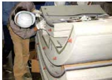
● シーコークの貼付け作業(セグメント組み立て前)
