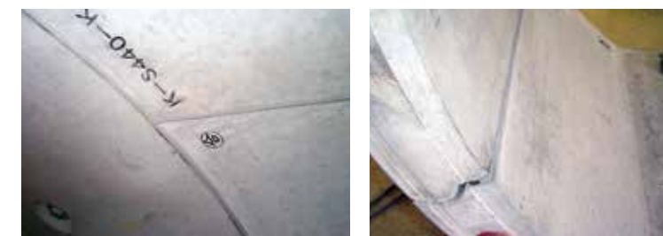
●施工後の継手溝部 ●施工時のねじれもありません。
