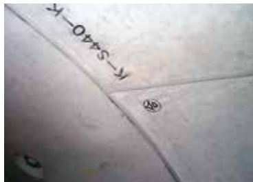
● 施工後の継手溝部
