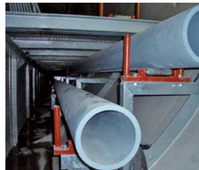
処理場連絡管路（汚泥管路）
