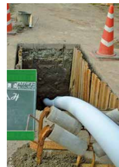
推進工事（HDD 工法）
