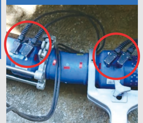
EF両受バンド 同時通電施工事例
