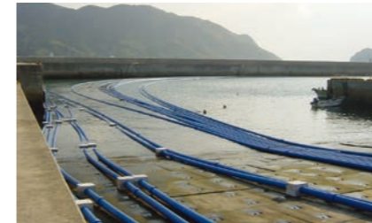
海洋深層水取水(海底配管)
