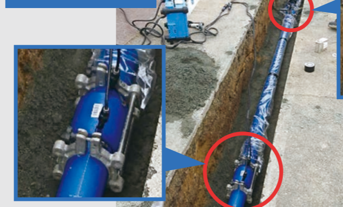
EFソケット+EFソケット 同時通電施工事例
