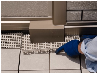
スキマの大きさに合わせて 切断した幅調整材を差し込む。
