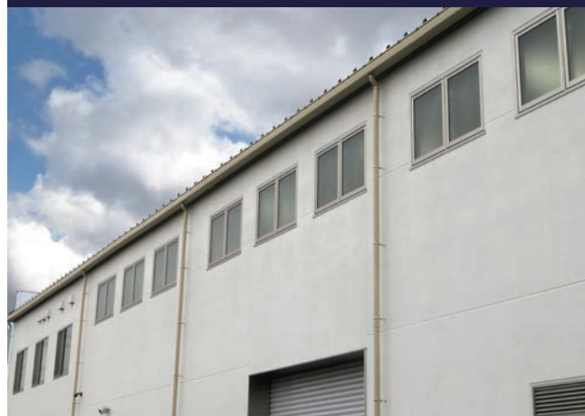
愛知県春日井市 事務所兼倉庫 | 超芯V500+高排水VU75 屋根投影面積:1,200m 2 /建物高さ:10m
