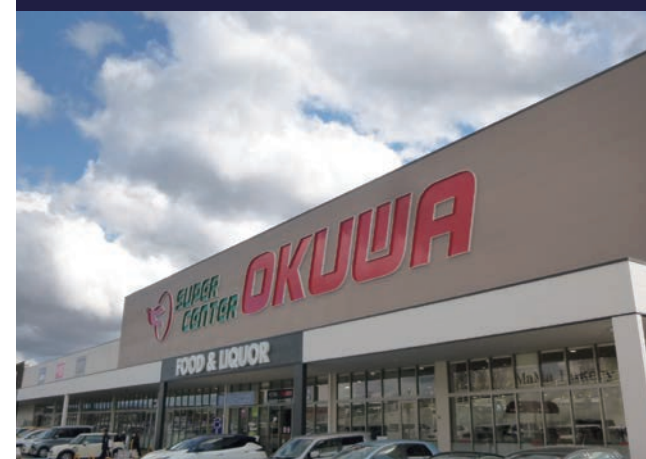
岐阜県多治見市 店舗 | 超芯V500+高排水VU75 屋根投影面積:5,000m 2 /建物高さ:6m
