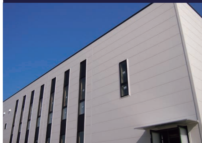
千葉県茂原市 事務所 | 超芯V500+高排水VU75 屋根投影面積:1,500m 2 /建物高さ:10m
