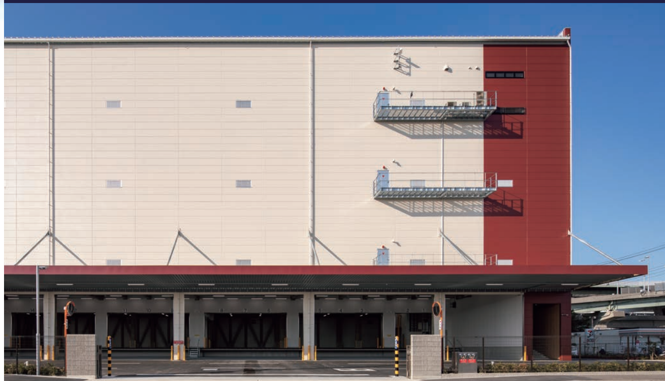
大阪府大阪市 物流センター | 超芯V500+高排水VU75 屋根投影面積:4,300m 2 /建物高さ:28m
