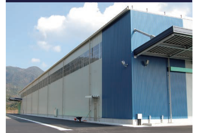
福岡県直方市 工場 | 超芯V500+高排水VP75 屋根投影面積:4,000m 2 /建物高さ:9m
