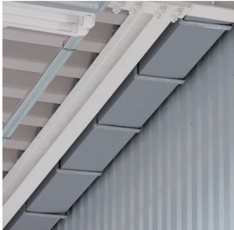
エスロコイル施工例
