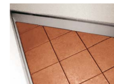
変形のバルコニーの端部
