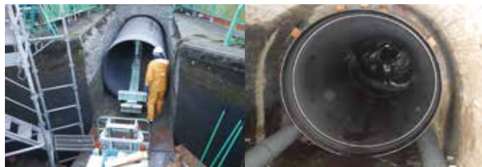
福岡市南畑隧道(内挿管φ1650)
