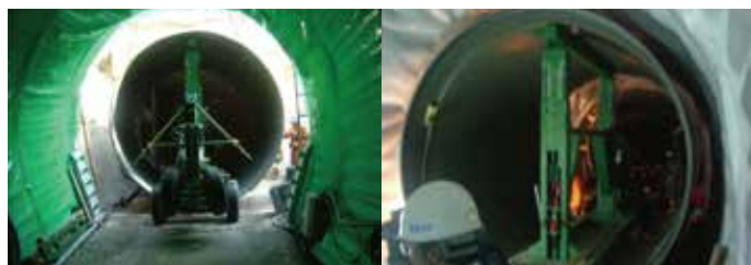
池田市配水隧道(内挿管φ3250)
