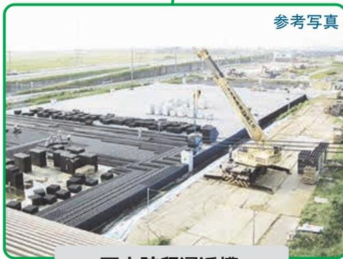
プラスチック貯留構造体を用いた、地下貯留浸透槽。地下インフラ概念図で示した箇所以外に、戸建住宅の駐車場下、商業施設の駐車場下に整備し、雨水を溜めながら地中へ浸透させる。
