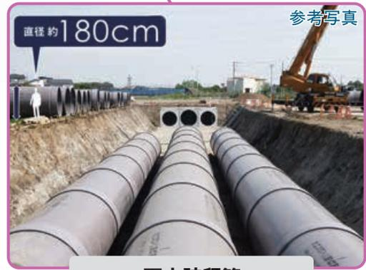
直径 約 180cm の強化プラスチック複合管に雨水を一時的に貯留し、少しずつ下水道へ放流。
