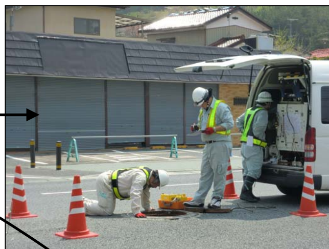
下水道幹線の2次調査
