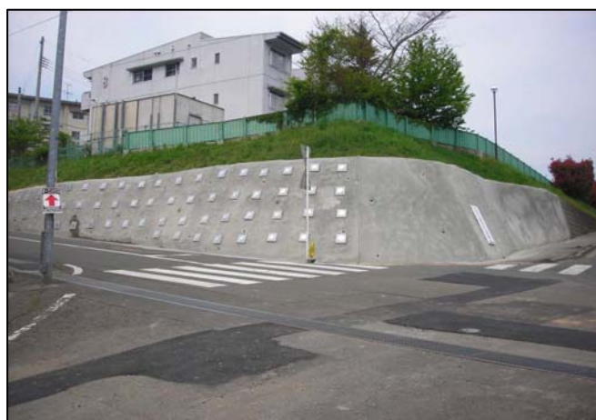
宮城県営折立団地の擁壁補修工事現場
