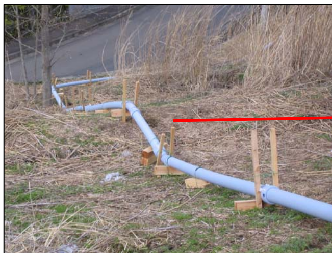
高台の住宅まで、呼び径100mmで 急傾斜地を仮設配管(約130m)
