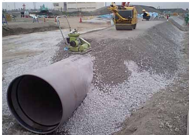
【突出形碎石・C-40】某空港 φ900(外圧2種管)
