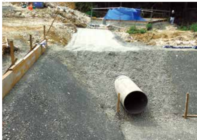
【突出形碎石・C-40】某空港 φ900(外圧2種管)
