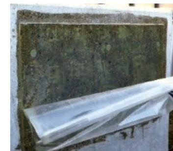
硬化後に必ず保護フィルムを剥がしてください。
