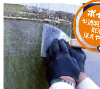
シート中の気泡を金属へら、ローラー等で脱泡してください。
