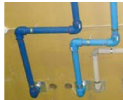
天井部エルボ返し付近(保温が必要です。) (左:エスロハイパー-AW 右:エスロハイパー-AW HP)
