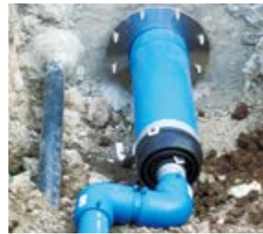
基礎耐震施工状況
