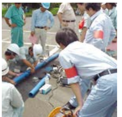
施工講習会風景
