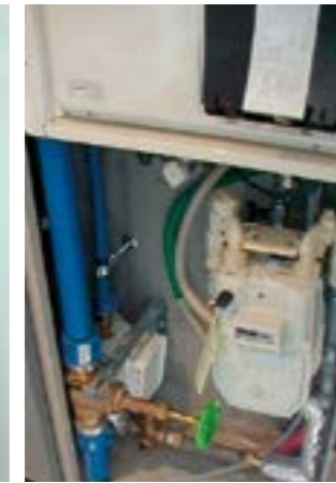
最下階ゲートバルブ付近
