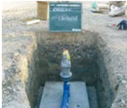
埋設消火配管
