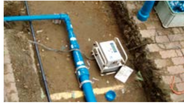
外構配管施工
