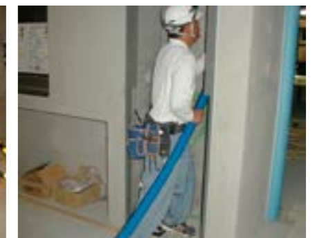
柔軟性を活かしたPS内への管の挿入
