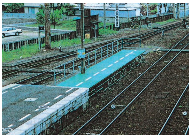
プラットフォーム延伸工事
