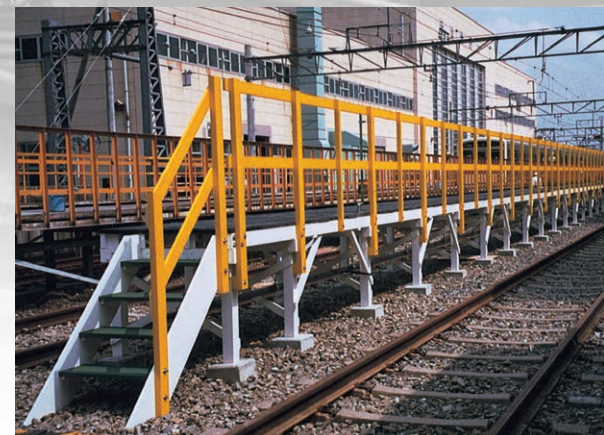
洗車場デッキ
