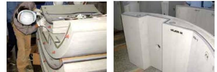
●シーコークの貼付け作業(セグメント組み立て前) ●シーコークの貼付け完了
