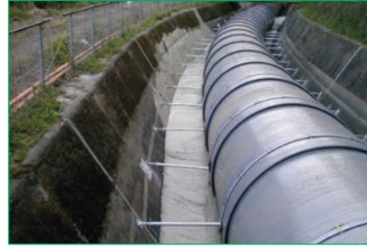
開水路改修(曲げ配管)
